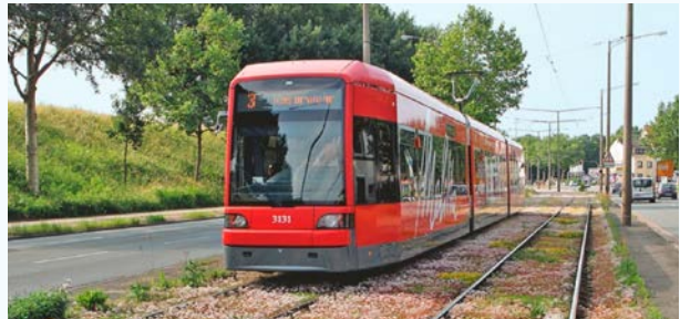
Sedumgleis in Bremen auf der Linie 3
